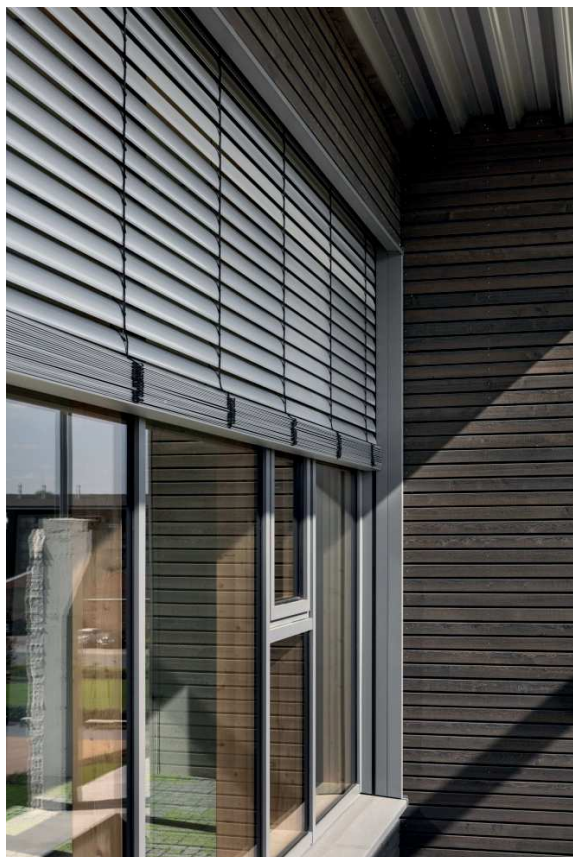
Lamellen-Raffstore - verstellbar + motorisiert Stores à lamelles orientables - motorisé
